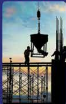
THI CÔNG XÂY LẬP
